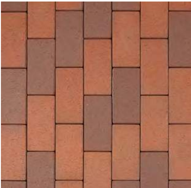
Läuferverband, halbversetzt
