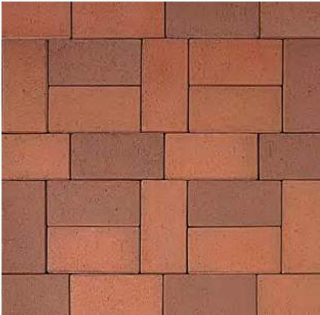
Blockverband mit Läuferreihe
